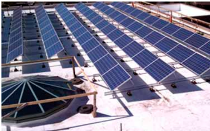
Fig. 5.22 – Sistema de fixação em telhado plano. A distância entre as fileiras é definida a partir do trade-off entre perdas por sombreamento e área aproveitada.
