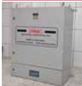
Ohmic Resistores apresenta Falcohm seu novo sistema de aterramento de alto valor ôhmico com supervisão microprocessada e interface via ethernet, efetuando detecção e pesquisa de defeitos, teste do sistema, proteção, sinalização, relatórios com gráficos, etc. Módulo Falcohm, a sentinela silenciosa.
