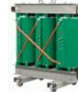
Os transformadores de Média Tensão a Seco Blutrafos não sofrem com umidade, são ecologicamente corretos, não apresentam risco de explosão. Oferecem economia na obra e redução nas perdas e quedas de tensão. Não utilizam relés de gás, indicadores de nível, manômetros e válvulas. São certificados CRCC Petrobrás.
