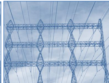
Transmissão em Ultra Alta Tensão
